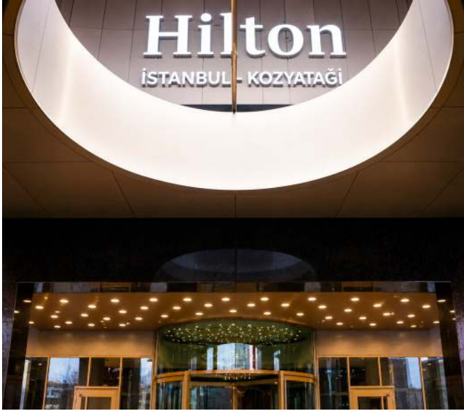
Lobby giriş dış mekan
